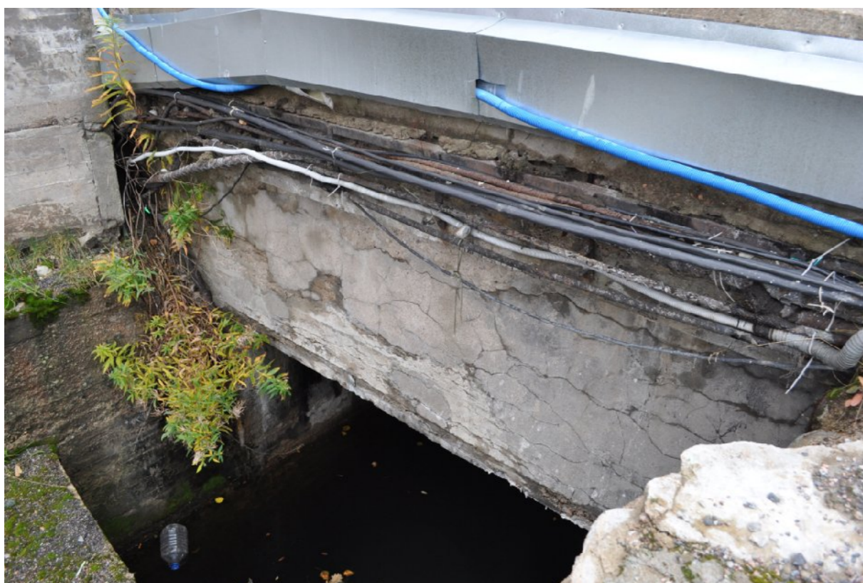
Пролетное строение L_{3-4} над бревноспуском
