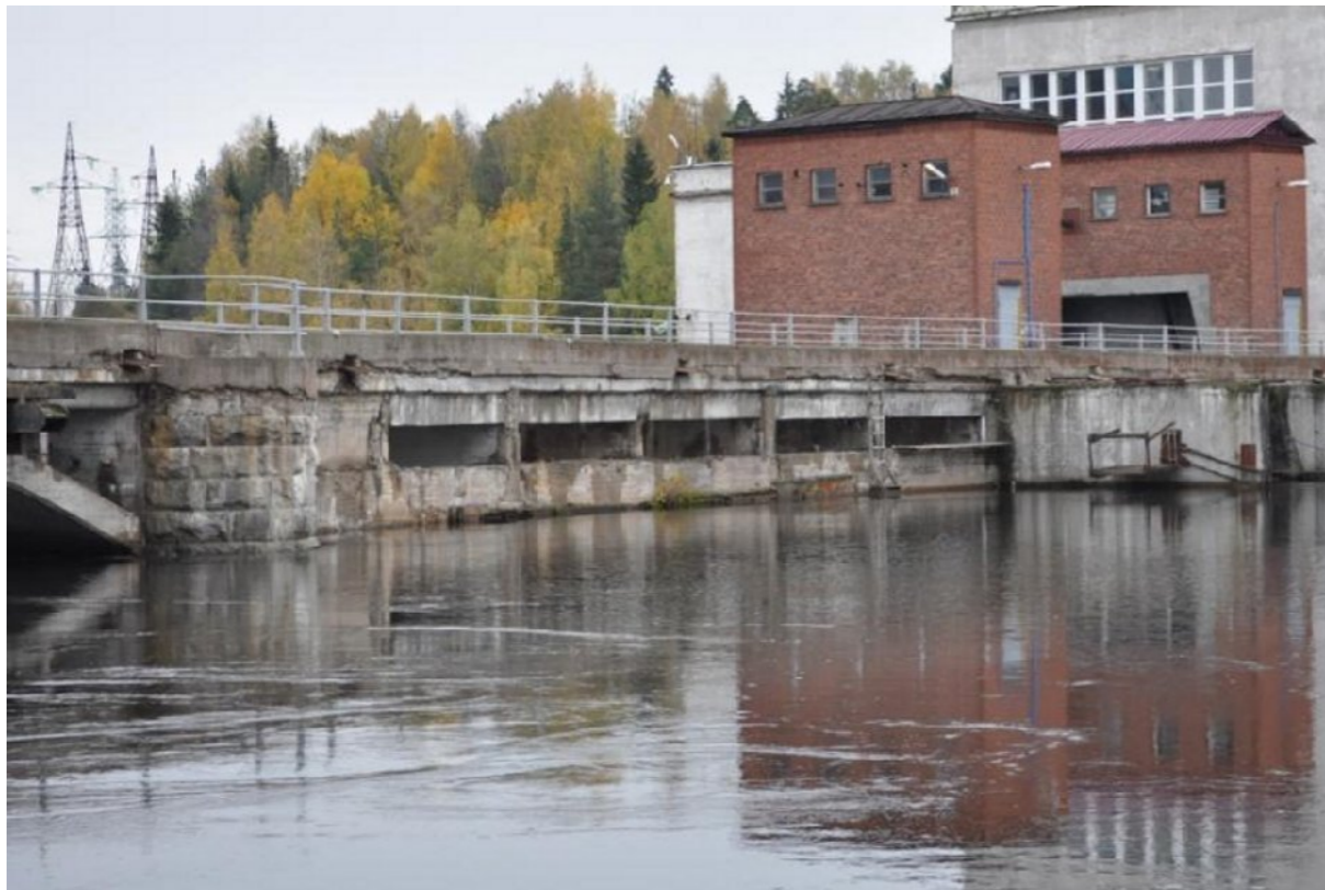
Со стороны верхнего бьефа
