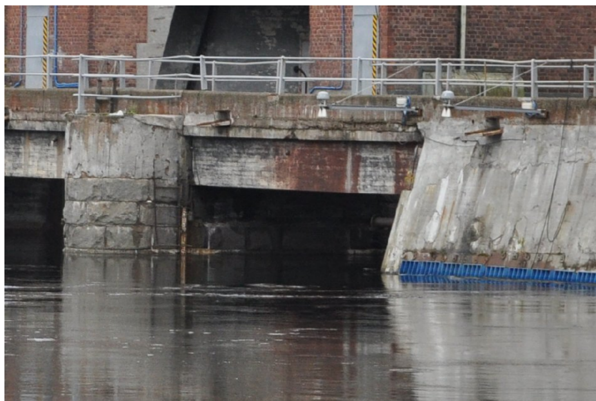
Пролетное строение L_{5-6} над ледосбросом
