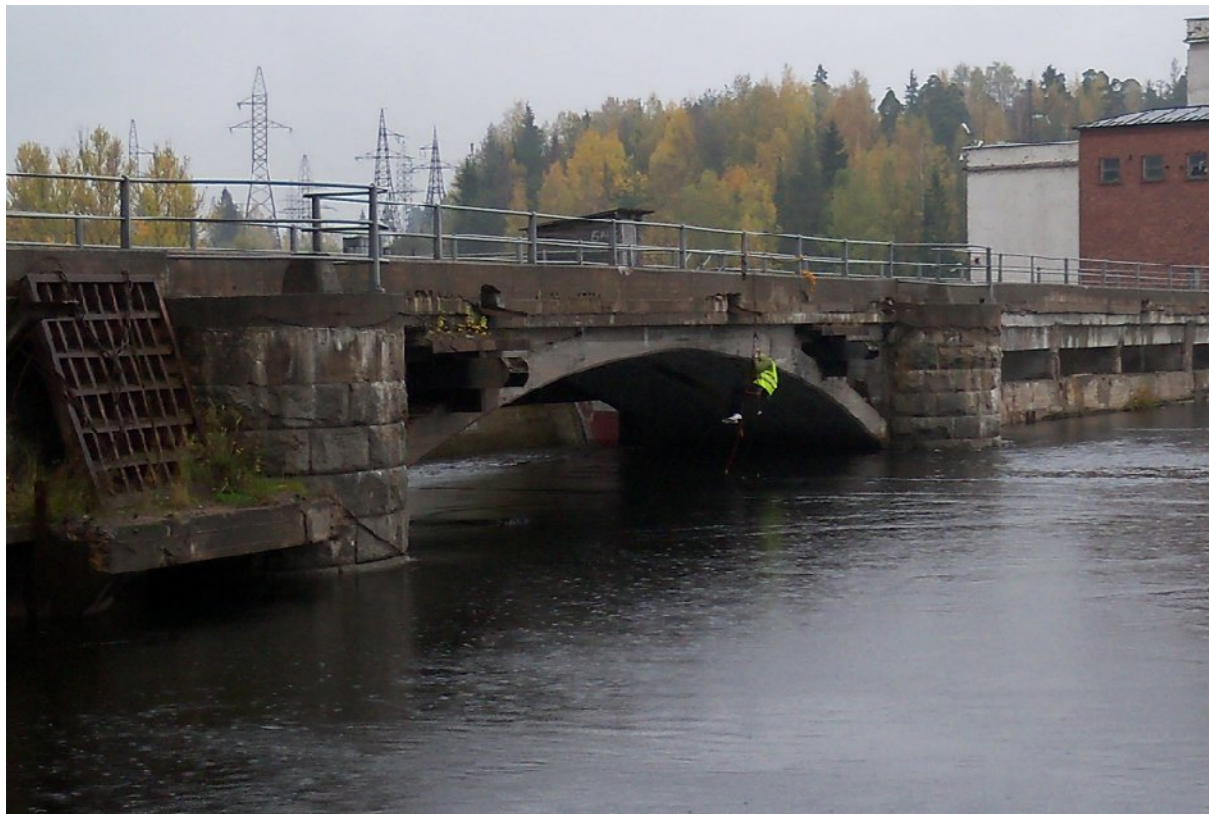
Со стороны верхнего бьефа
