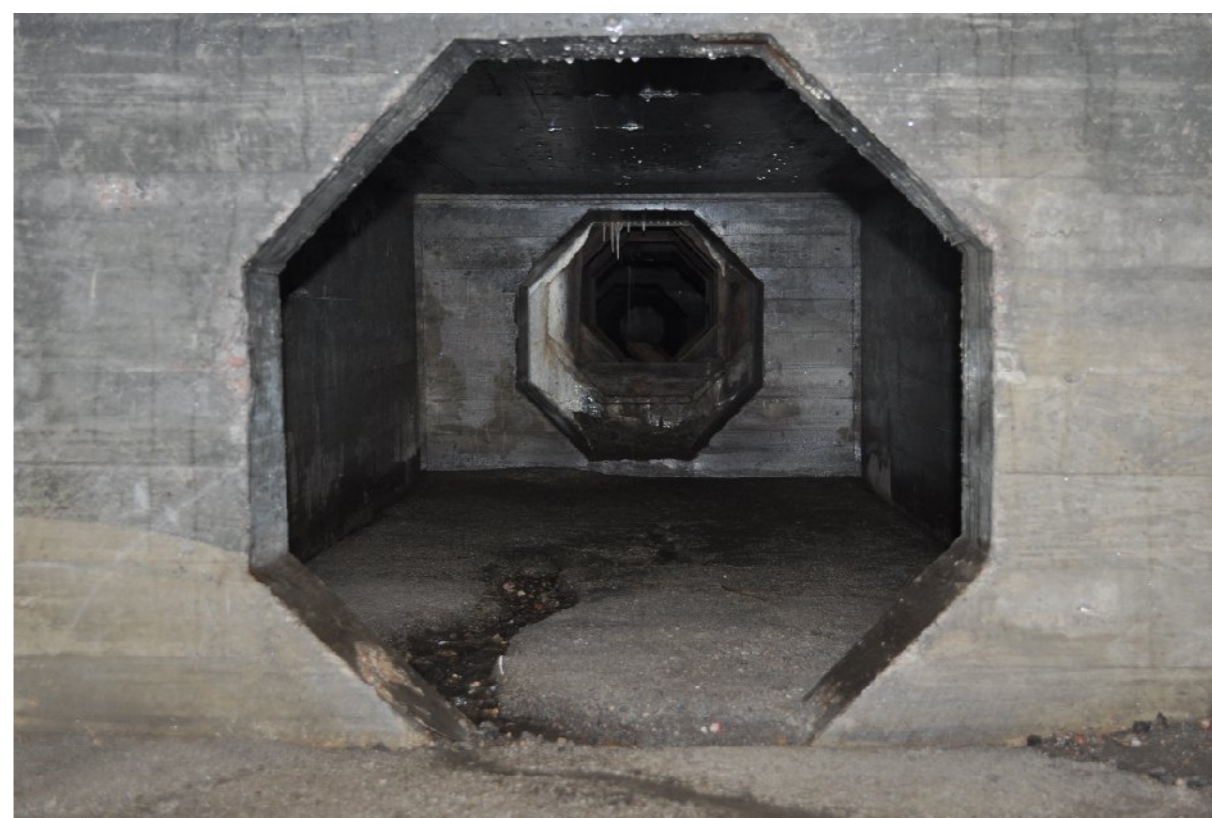
Пролетное строение L_{4-5} : вид изнутри сечения
