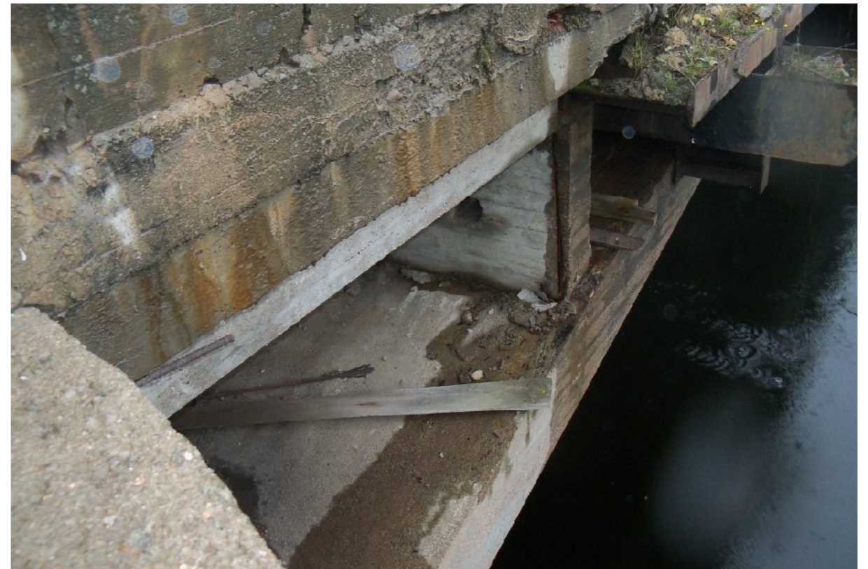
Вид со стороны опоры №1
