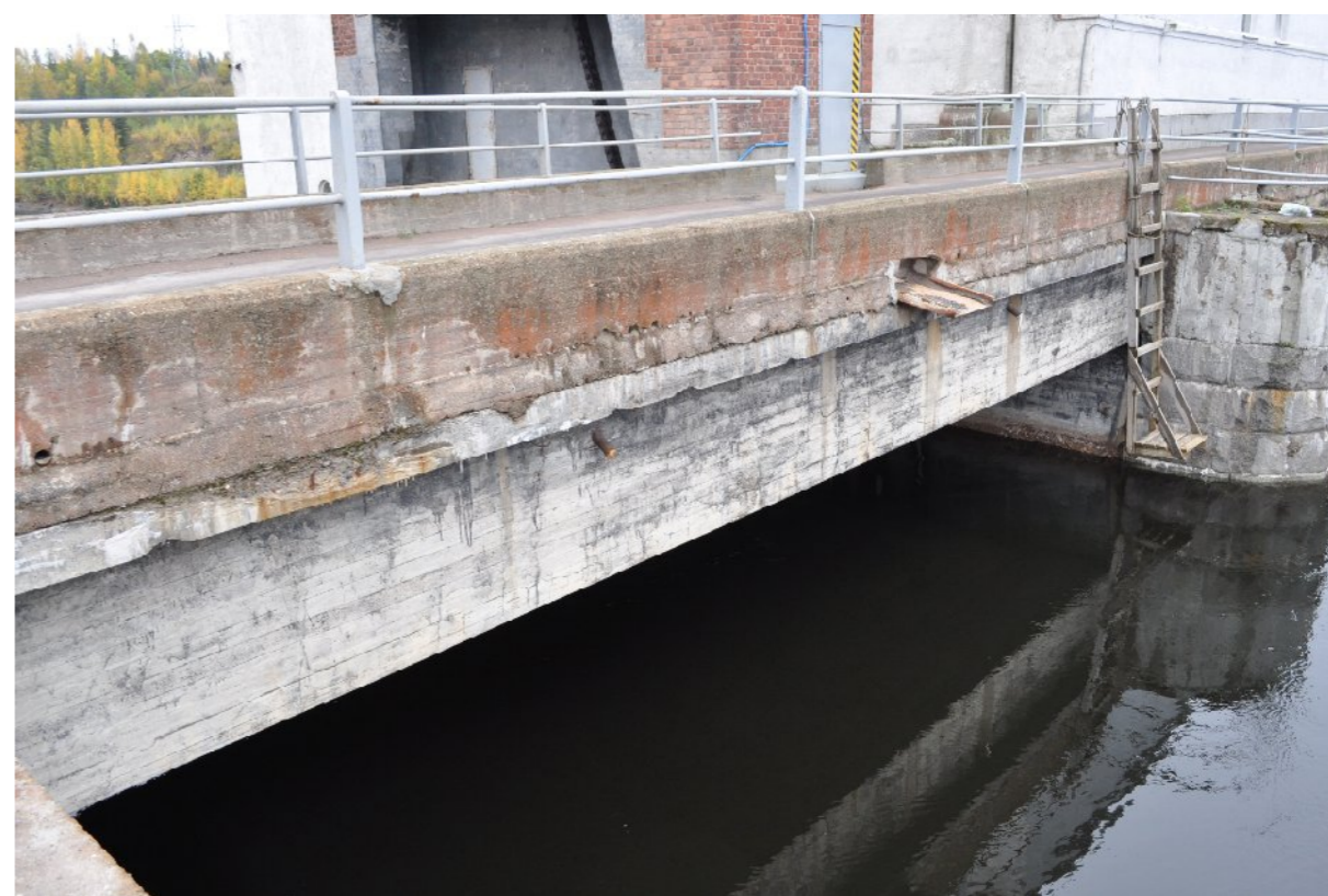
Пролетное строение L_{4-5} над малым водосбросом
