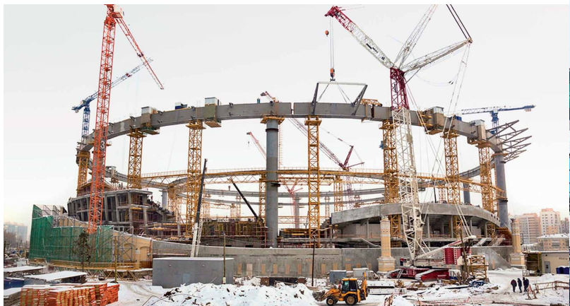
Строительство объекта «Екатеринбург Арена»
