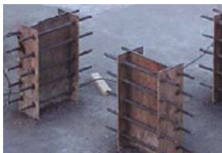
Рис. 2.6. Анкерные упоры стальных свай
