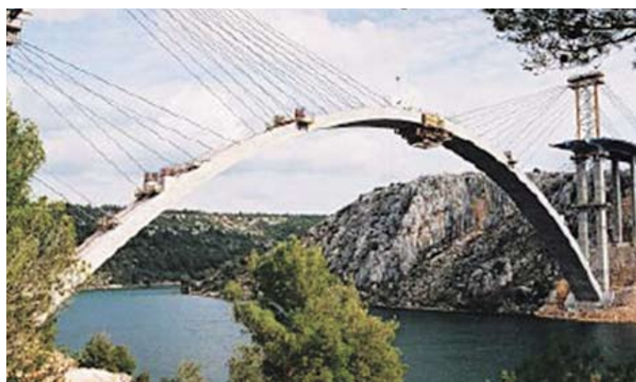
Рис. 4.10. Монтаж арки моста
