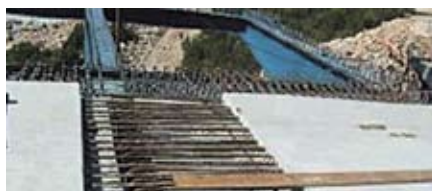
Рис. 4.9. Стык арматуры на участке омоноличивания
