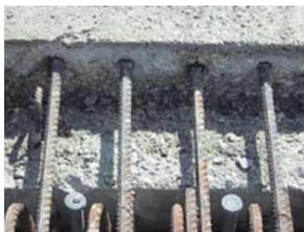
Рис. 4.8. Стык плиты на обработанном участке
