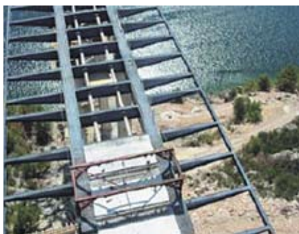
Рис. 4.7. Размещение сборных плит
