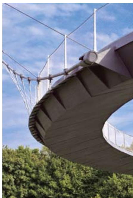
Рис. 8. Поперечный аэродинамический обтекатель
