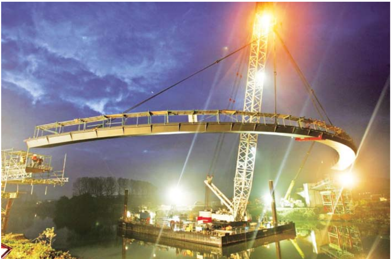
Рис. 14. Монтаж центральной секции пролетного строения плавучим краном
