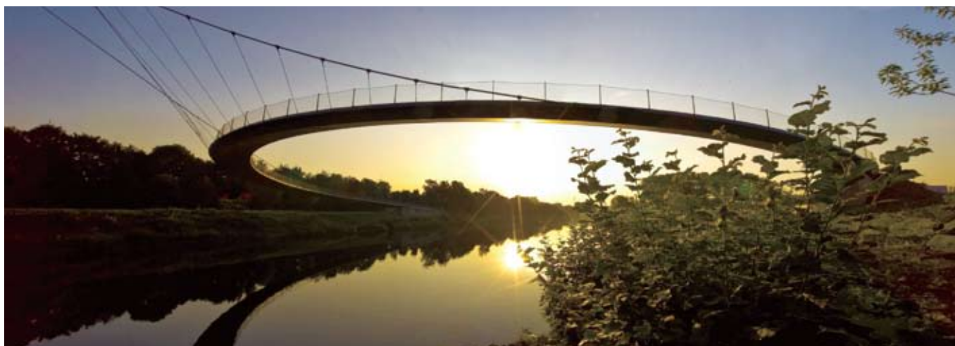
Рис. 16. Вид на мост с южного берега
