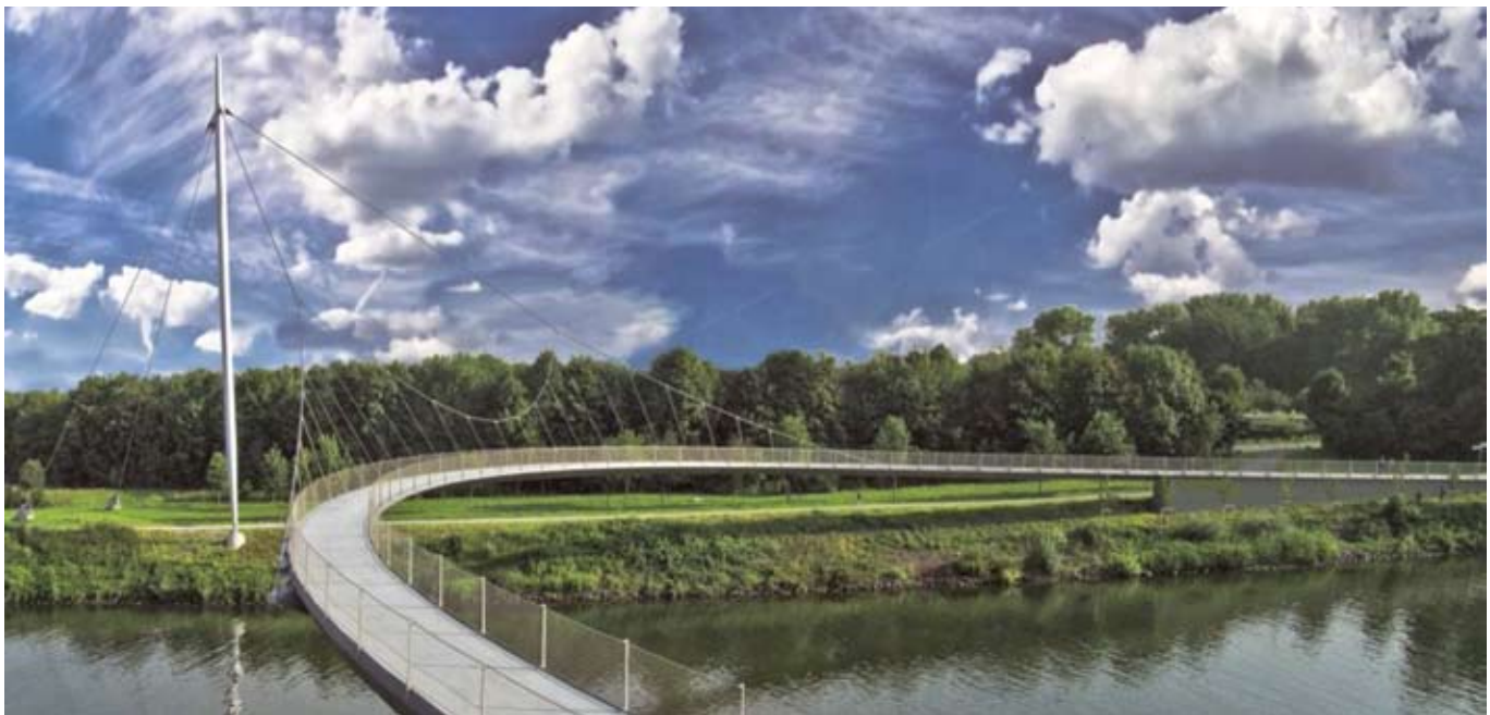
Рис. 5. Система подвески
