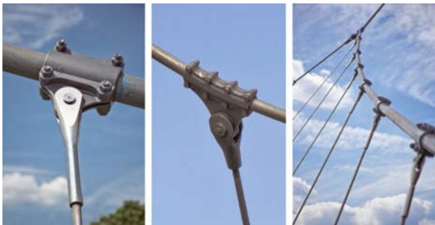
Рис. 10. Фрезерованные стяжные хомуты канатов
