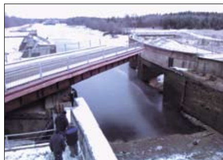
Наводка моста осуществляется поворотом пролетного строения на 90°
