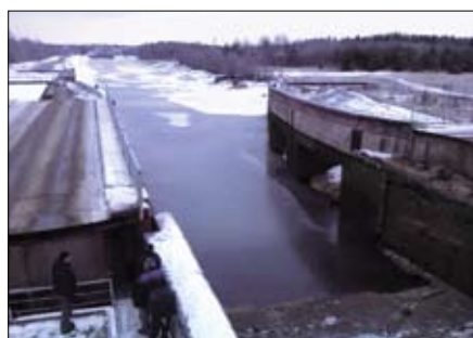
Наводка моста осуществляется поворотом пролетного строения на 90°
